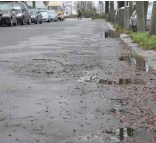
Tatsächlich befindet sich die Straße in einem bedenklichen Zustand. Die Fahrbahn weist deutliche Schadstellen im Oberflächenbelag und teilweise auch an den Bordsteinanlagen auf. Verschiedene Abschnitte sind charakterisiert durch Frostaufbrüche, Rissbildungen, Flickstellen und Schlaglöcher. Ebenso sind aus der Vergangenheit Eingriffe von Versorgungsunternehmen erkennbar.
